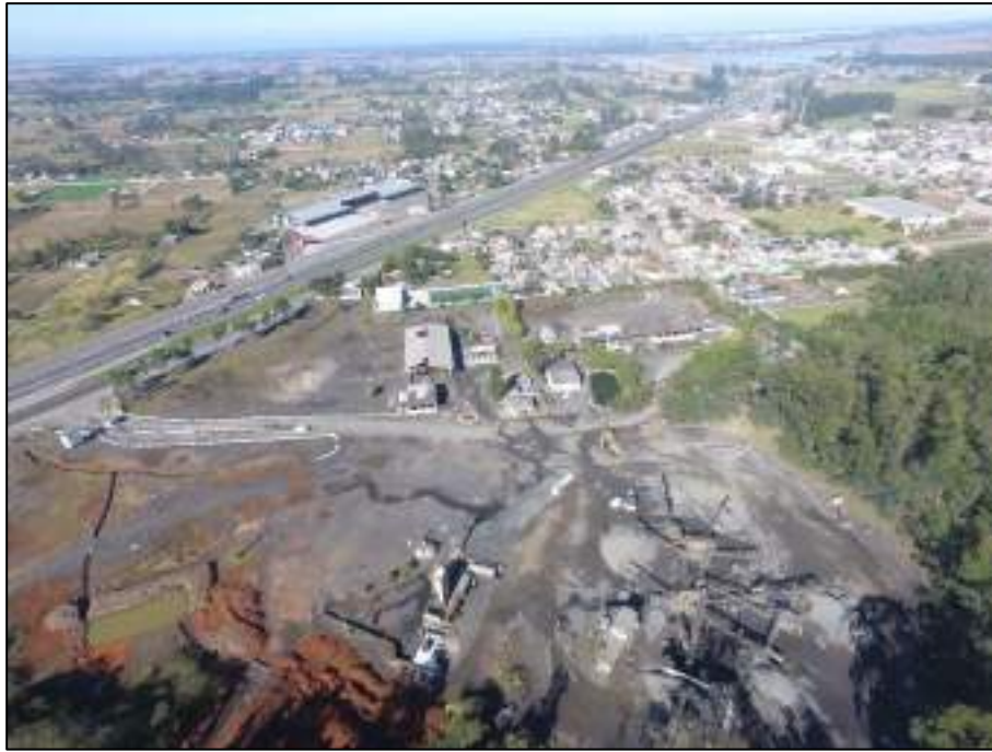
Figura 3-5: Área de britagem na porção sul da jazida Maracaja.
