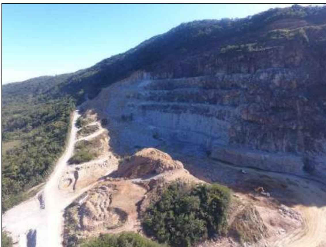
Figura 5-4: Vista geral da frente da lavra interligada da Cedro Engenharia e da SAIBRITA.
