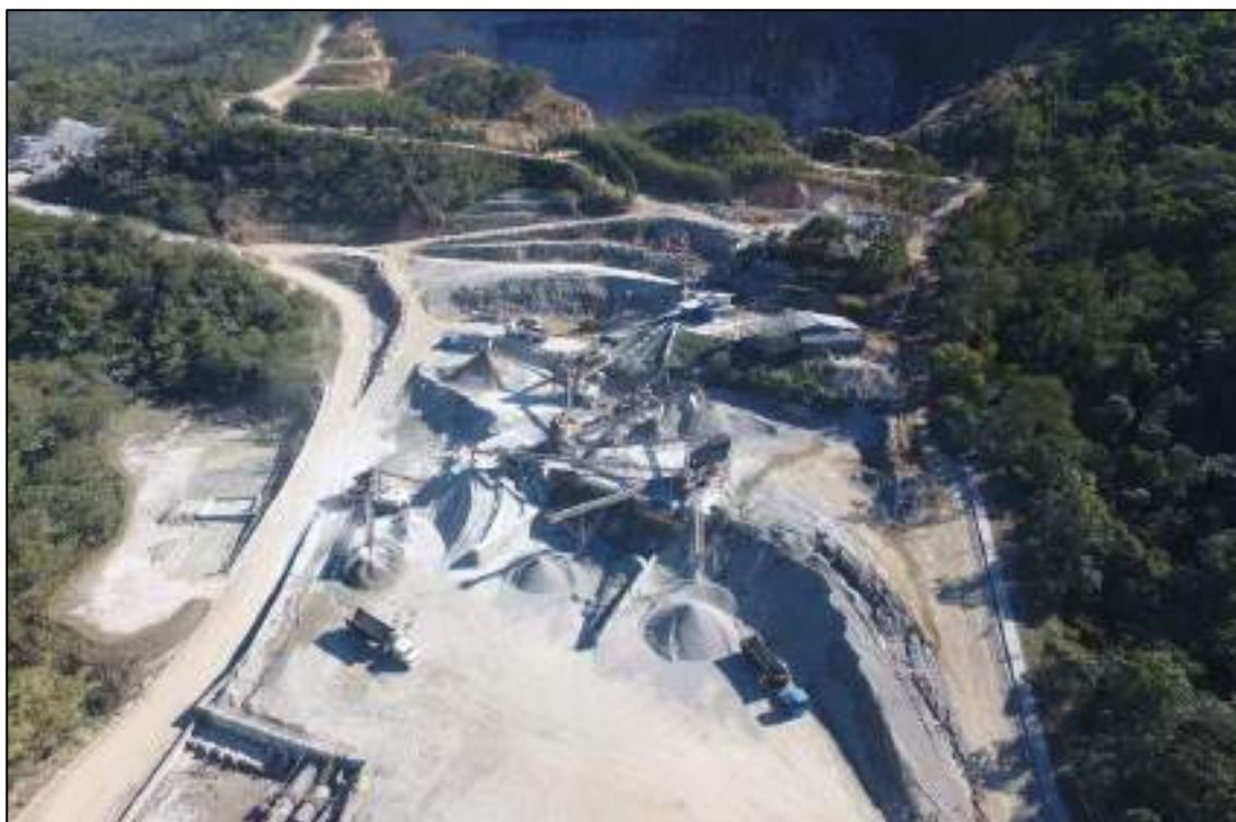
Figura 5-6: Detalhe para britagem instalada próxima à área de estudo.
