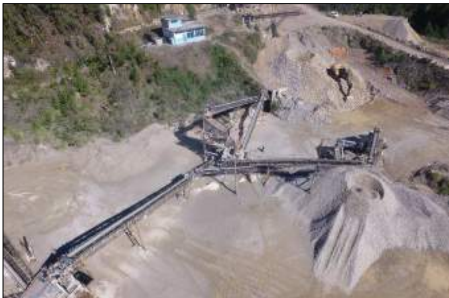
Figura 4-5: Detalhe para a britagem instalada na porção leste da área de estudo.
